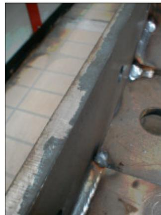
Schweißkonstruktion aus lasergeschnittenen Blechen. Teile der Oxydschicht (blaugrau) sind schon während der mechanischen Bearbeitung abgeplatzt. Strahlen ist auch wegen der Schweißschmachaupuren unabdingbar notwendig.
