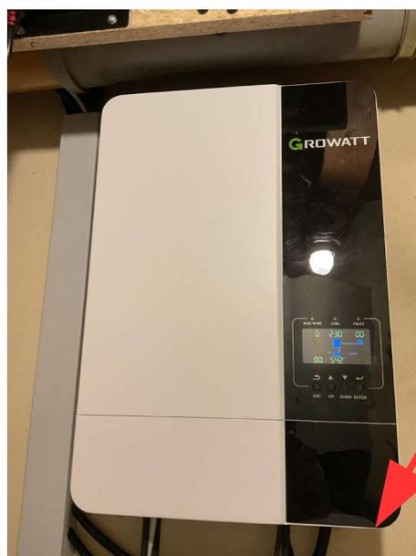
Unten rechts hinten am Gehäuse befindet sich der **EIN/AUS Wippschalter**
