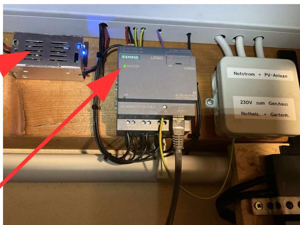
Abbildung 12: SPS mit Spannungsversorgung
