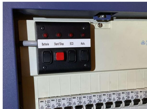
Abbildung 15: Schaltableau Generator
