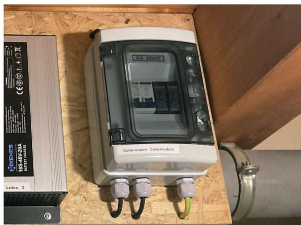
Abbildung 10: Überspannungsschutz PV
