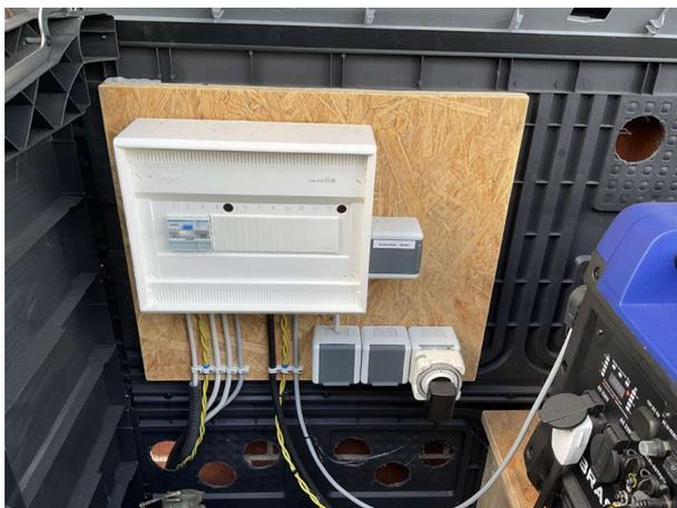
Abbildung 3: Timer für Batterieladung
